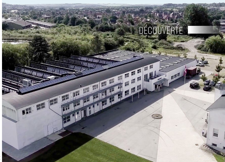
Siège social et ex-unité de fabrication d'Aalborg.
